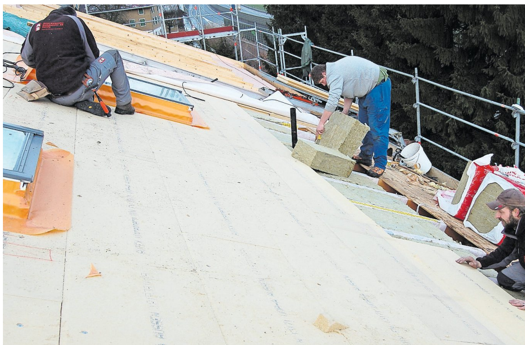
Eine Dachsanierung in Beckenried.
