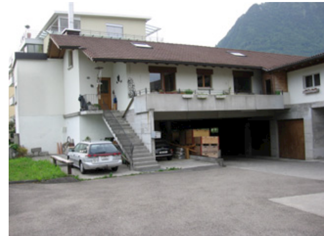
Anbau mit einer 5 Zimmerwohnung
