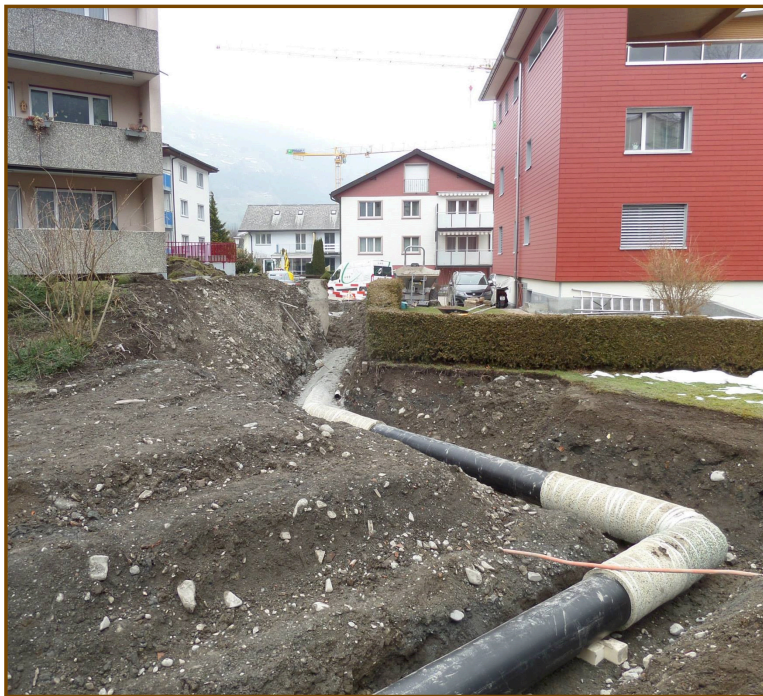
Während dem Bau
