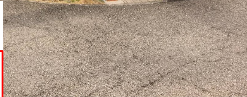
Parkplatz Spital, Stans
