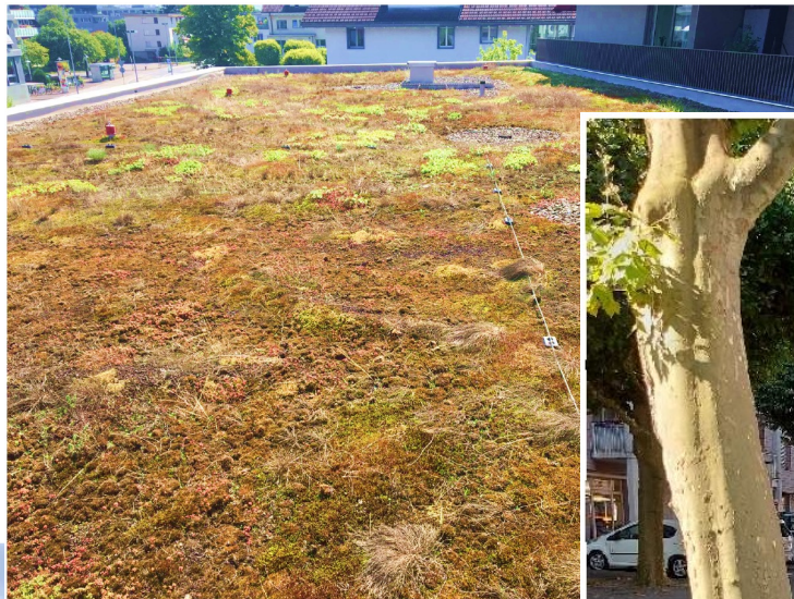
Bürogebäude Stansstaderstrasse, Stans
